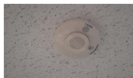
⑤ 設置完了！！
